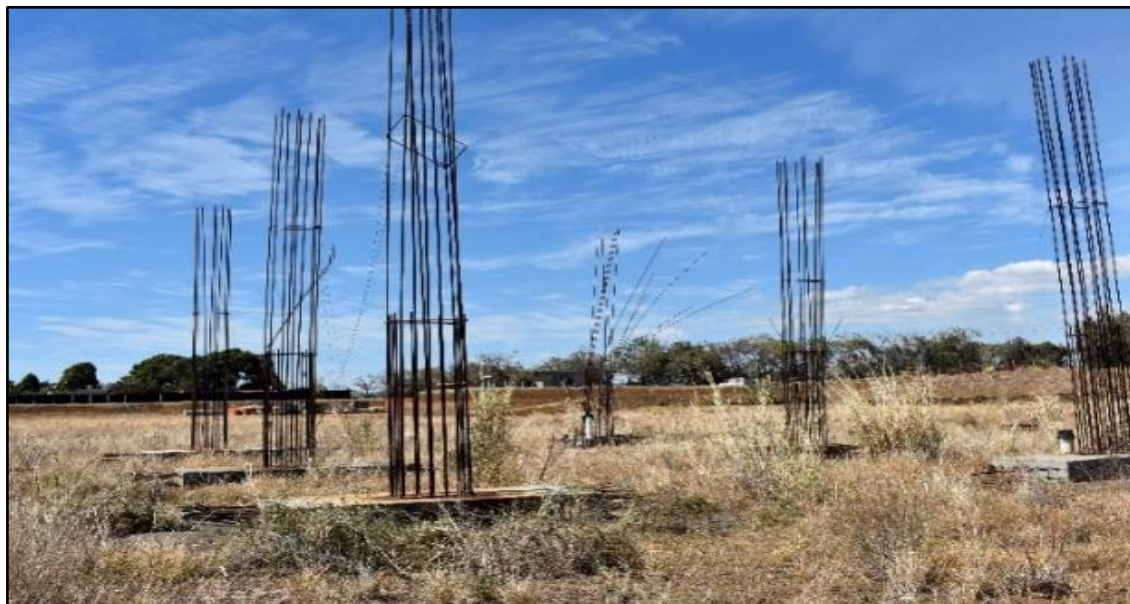
Fotografía №12 Ejemplos de encepados construidos en el sitio
