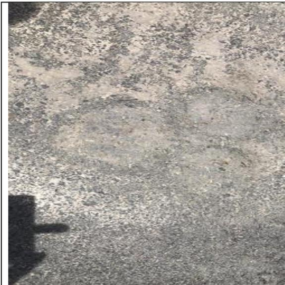
**Fotografía N° 23. Huellas de muestras de núcleos de asfalto.**
