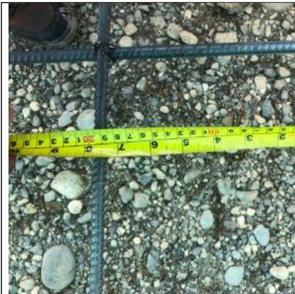
**Fotografía N° 15. Revisión detallada de las armaduras.**
