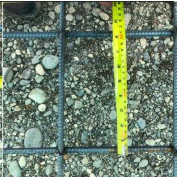
**Fotografía N° 16. Revisión detallada de las armaduras.**
