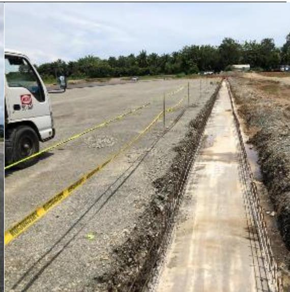
**Fotografía N° 12. Canal pluvial en proceso de construcción.**
