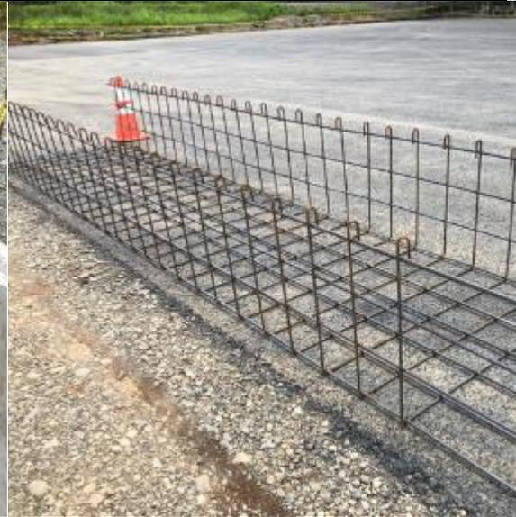
**Fotografía N° 22. Armadura para canales pluviales.**
