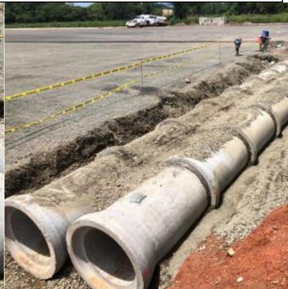
**Fotografía N° 8. Tuberías de desfogue.**
