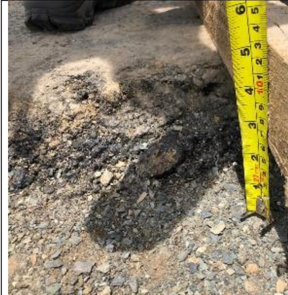
**Fotografía N° 9. Espesor de la carpeta de asfalto**
