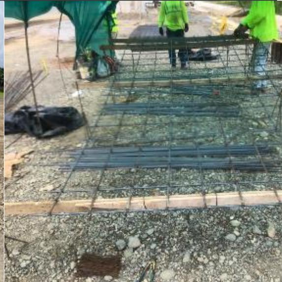
**Fotografía N° 14. Armadura de canal.**
