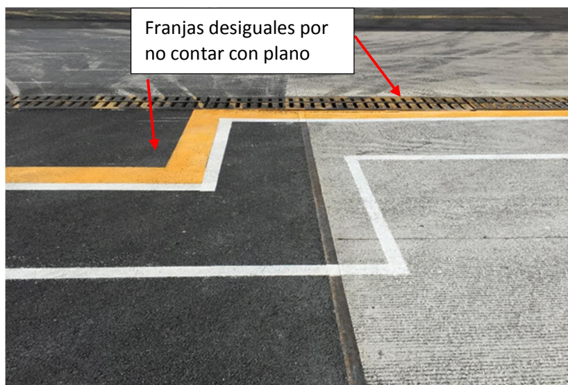
Imagen 3 Demarcación de la línea de Rampa
