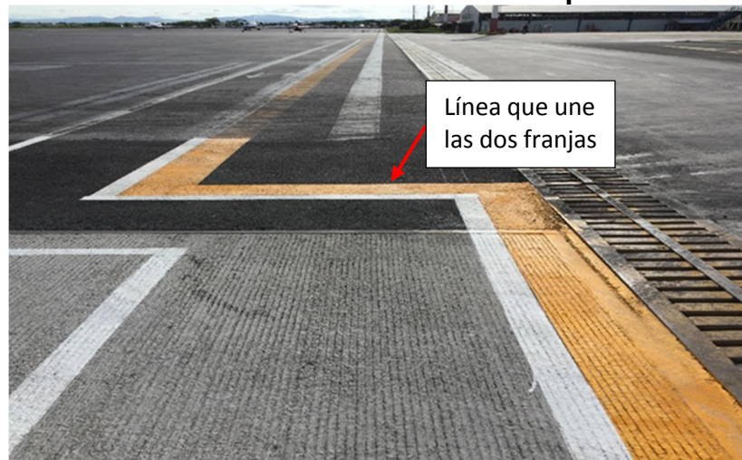
Imagen 2 Demarcación de la línea de Rampa
